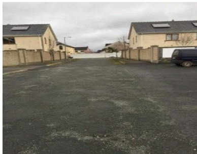
Inis Álainn roimh na hoibreacha
