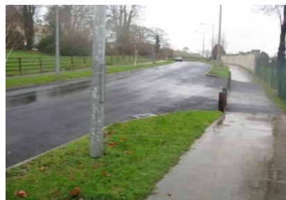
Bóthar Rochtana Aylesbury tar éis na n-oibreacha
